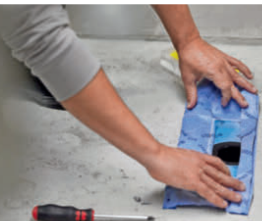
Links: Dank des werkseitig vormontierten Dichtvlieses lässt sich die Duschrinne effizient und sicher einbauen.
