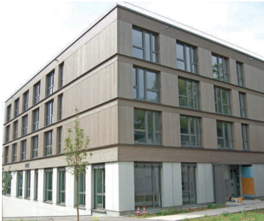
Das Dialysezentrum mit angeschlossenem Wohnheim in Heidenheim entstand in Modulbauweise.
