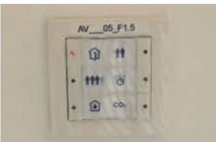
Mit dem Tastsensor InControl lassen sich mehrere Lüftungsstufen und Programme individuell einstellen.
