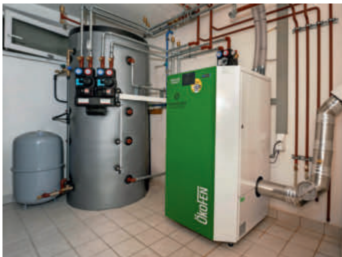
Die alte Ölheizung weicht der Pellematic Condens mit ZeroFlame® Technologie.
