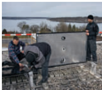
Die Monteure installieren 228 Photovoltaik-Thermie-Module am Dach.
