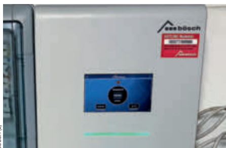
Der Wärmepumpenmanager steuert Heizung, Warmwasser und Kühlfunktion der Anlage.
