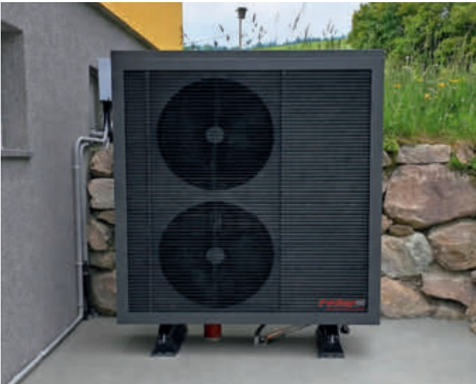
Die Wärmepumpe AeroWIN DELUXE von Windhager sorgt für besonders effizientes und leises Heizen und Kühlen.
