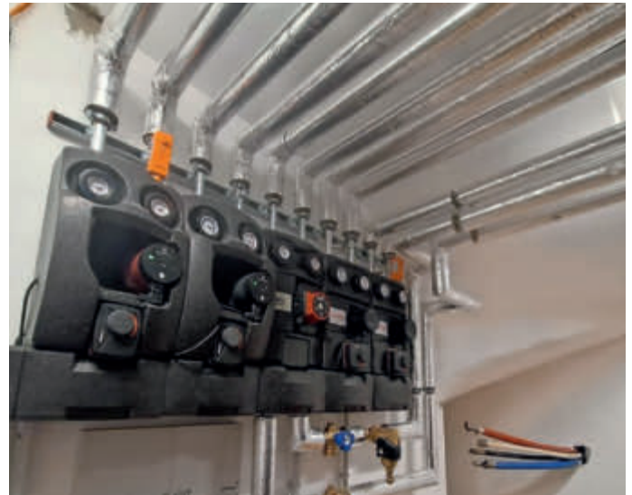
Der Wandverteiler von Windhager mit Energiesparpumpen: Damit Wärme und Kälte immer punktgenau im Wohnraum ankommen.
