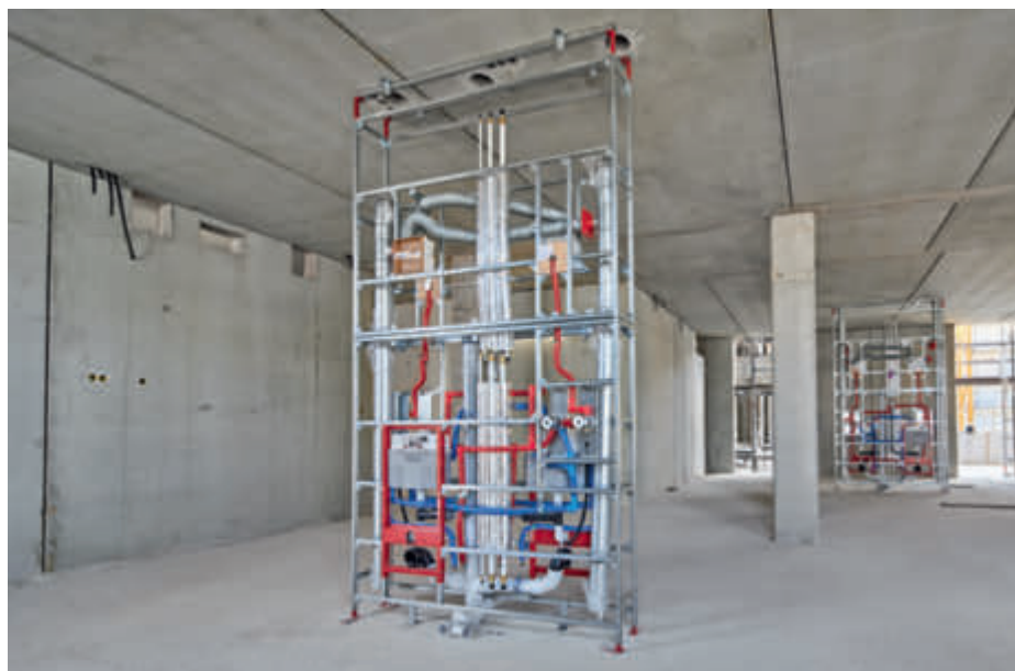
Blick auf ein bereits einseitig beplanktes raumhohes Trennwand-Modul.
