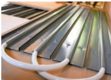
Vorkonfektionierte Wandheizung: Das Heizrohr ist mit Wärmeleitmodulen an Gipsfaserplatten befestigt.
