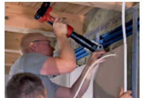
Die Wandmodule wurden am Trockenbau montiert und die Rohre über Presskupplungen verbunden.
