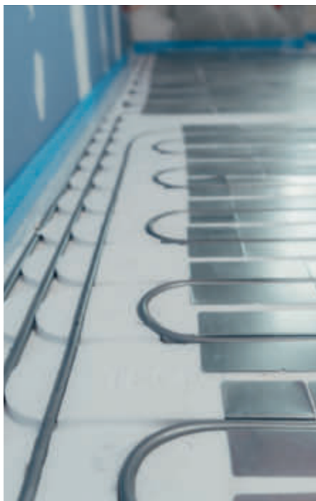
Detailaufnahme: In den Nuten werden die Aluminium-Verbundrohre von TECEfloor geführt.
