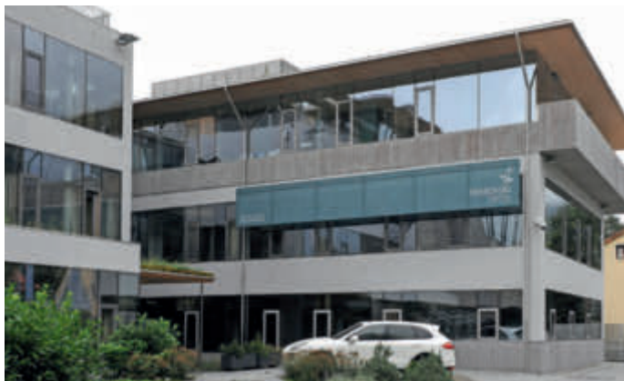
Im Zuge der Modernisierung der Unternehmenszentrale kamen Systeme von Harreither in der Produktion sowie in Büro- und Allgemeinbereichen zum Einsatz.
