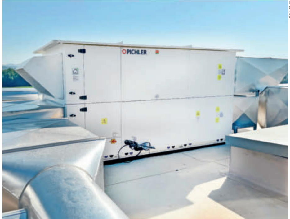
Energieeffizient im Wohnbau: PICHLERs Lüftungslösung LG 4000 WF ermöglicht die zentrale Belüftung der Wohneinheiten im Geschosswohnungsbau. Die Systemkomponenten werden zentral vom Dach gewartet.
