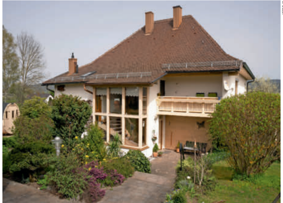
Das Zweifamilienhaus von Maria und Johann Stasny wurde 1924 errichtet. Für barrierearmes, altersgerechtes Wohnen zog das Ehepaar in die Erdgeschosswohnung – mit neuen Heizkörpern und einer Fußbodenheizung.
