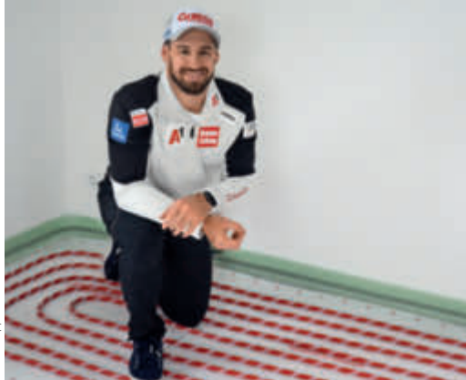
Wärme für den Weltcup-Skifahrer: Rennläufer Daniel Hemetsberger setzt auf eine Fußbodenheizung mit der Klett-Wärmerückstrahlmatte von JARAFLEX.
