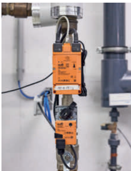
Links: Belimo Energy Valves messen und regeln Heiz- und Kühlenergie in einer Einheit.
