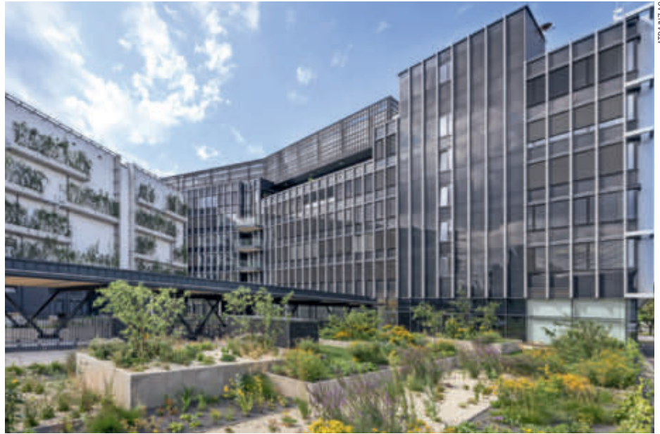
Im modernen Gebäude der LINZ NETZ GmbH arbeiten 330 Menschen. Ein Highlight im Haus ist die integrierte Fernkältezentrale mit einer Kälteleistung von mehr als fünf MW.
