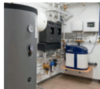
Nach Plan: Der Austausch der alten Ölheizung verlief unkompliziert.
