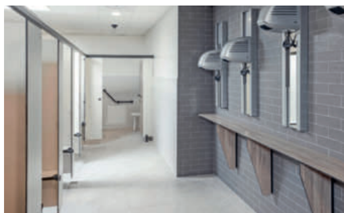
Im Duschbereich sorgt eine wandhohe Verfließen für pflegeleichte Oberflächen.
