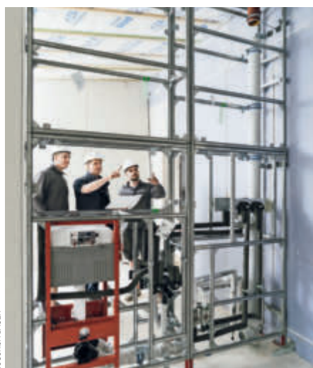
Bei Sanierung und Aufstockung eines Studierendenwohnheims in Passau sorgen TGA-Installationstrennwände mit Einblasdämmung für horizontalen und vertikalen Brandschutz.
