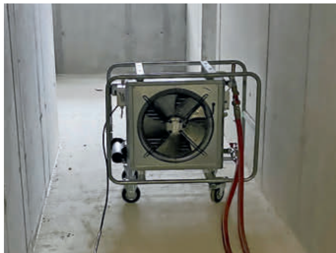
Ein mobiler ENERENT Lüfter mit 20 kW verteilt die Wärme im Rohbau. So entstehen auch bei Minusgraden geeignete Bedingungen für die Bauarbeiten.
