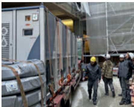
Die Pellets-Heizzentrale G200 wird vom LKW angeliefert und mittels Kran zum Aufstellplatz verho-
