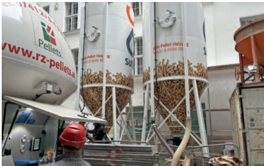
Mobiles Heizen am MedUni Campus Mariannengasse: Eine mobile Pelletslösung lieferte dafür insgesamt zwei Megawatt Heizleistung und brachte die Wärme über mehr als 800 Meter Warmluftschläuche in das Gebäude.
