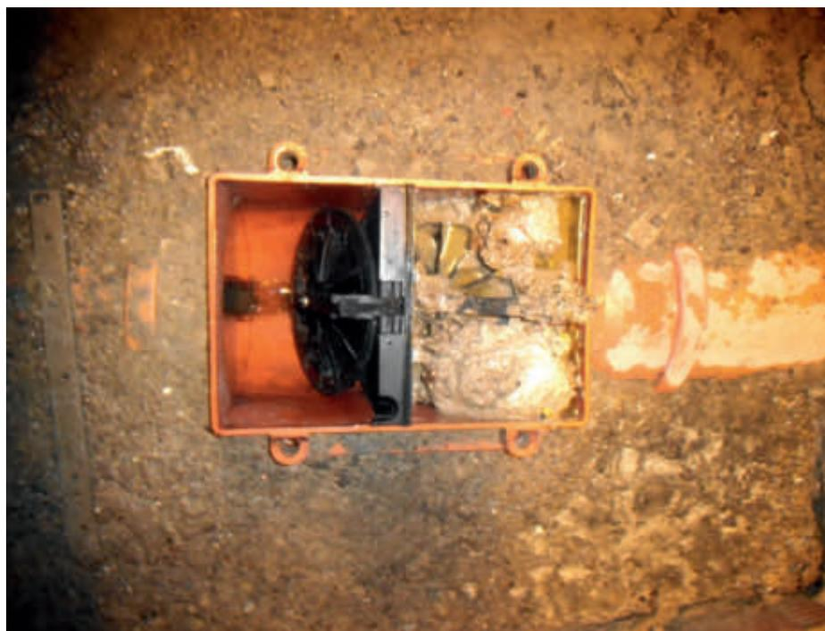
Verstopfung von Pendelklappen bei fäkalhaltigem Abwasser.
